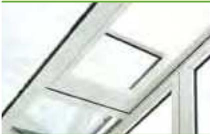
**Der Hebe-Schiebe-Lüfter**, eine moderne Form der klassischen Entlüftung im Dachbereich.
